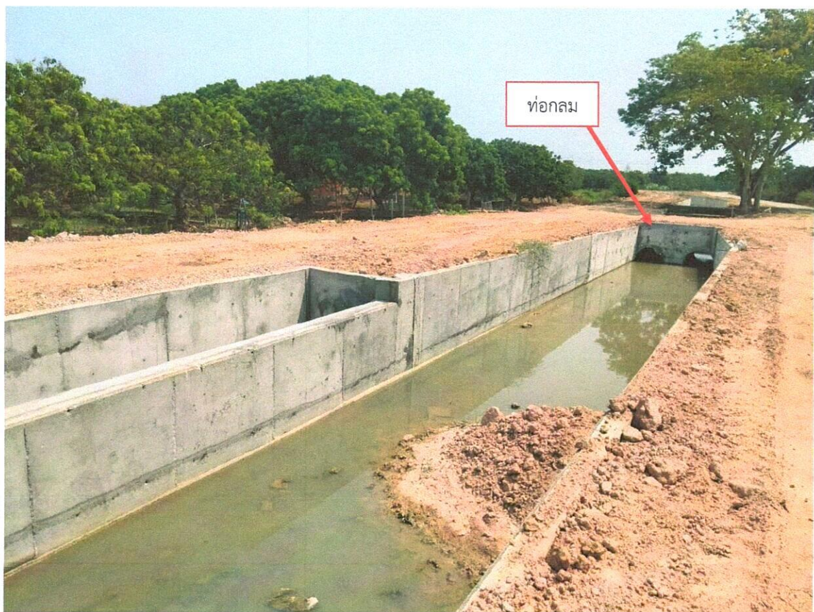
รูปภาพที่ ๒ ระบบส่งน้ำฝายสบร่องช่วงที่มีการก่อสร้างด้วยท่อกลม
