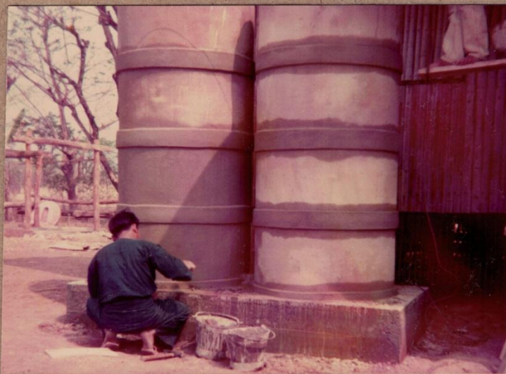
รูปที่ ๘. ถังเก็บน้ำฝน \phi 1.00 ม. สูง 0.50 ม. จำพวก 10 ท่อนและถังน้ำฝน จะเห็นของต่างๆ กำลังสร้าง.
